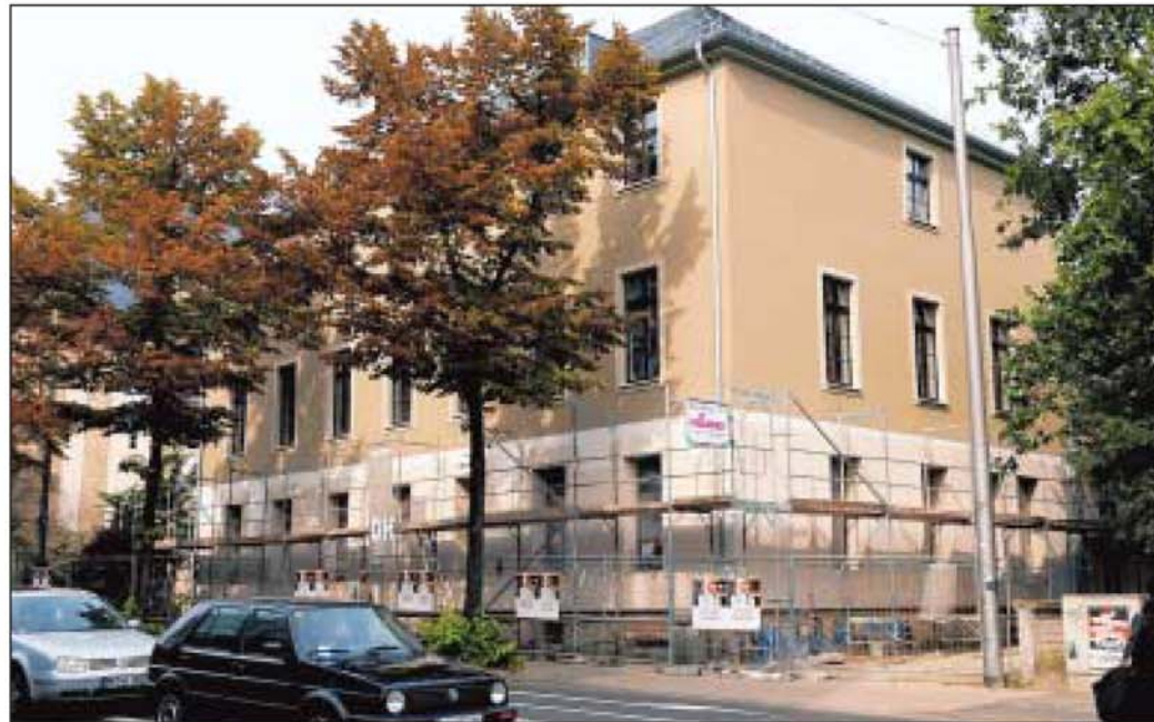
Mit neuem Outfit zurück zu den Wurzeln: Der Farbton der Fassade, ein Befund im Zuge der Sanierungsarbeiten, ist mit dem Denkmalamt abgestimmt. Foto: wita/Müller
