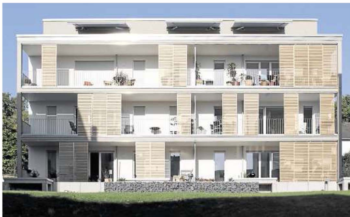
Mehrfamilienhaus in der Weidenbornstraße.
